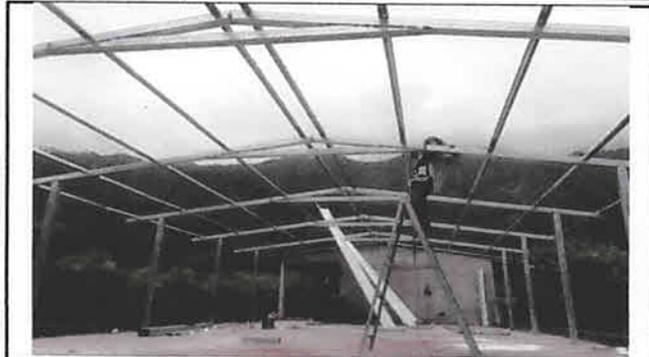
Foto 1: Estructura de metal e instalacion de techo para evitar que se siga deteriorando la terraza, ya que en epoca de lluvias se filtra el agua a las aulas del primer nivel y las paredes se mantienen humedas.
