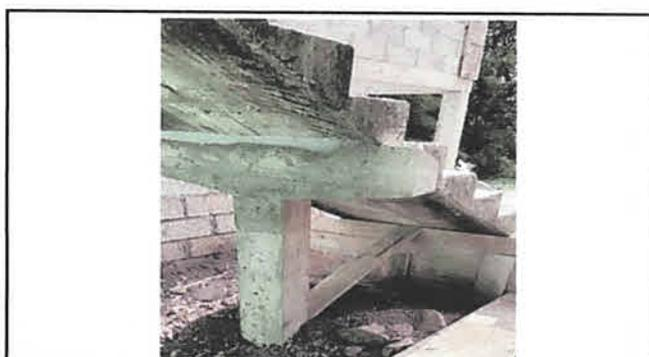
Foto 4: Reparación de gradas, ya que está falsa debido a que no fue reforzada con columnas.
