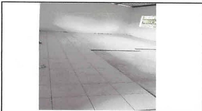
Foto 3: Instalación de piso cerámico en aula del segundo nivel, ya que el piso de torta es rústico y es incómodo para que los estudiantes tengan un espacio digno para recibir sus clases.
